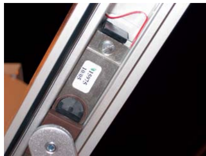
Detalle electroimán incorporado en la guía del cierrapuertas.
