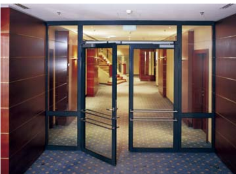
Sistema con retención electromagnética, selector de cierre y detector de humo integrado.
