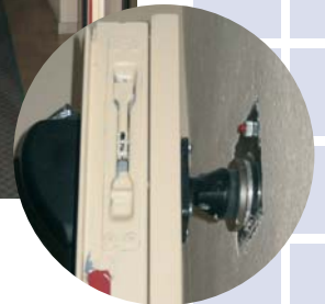
Sistema de retención electromagnética sobrepuesto.
