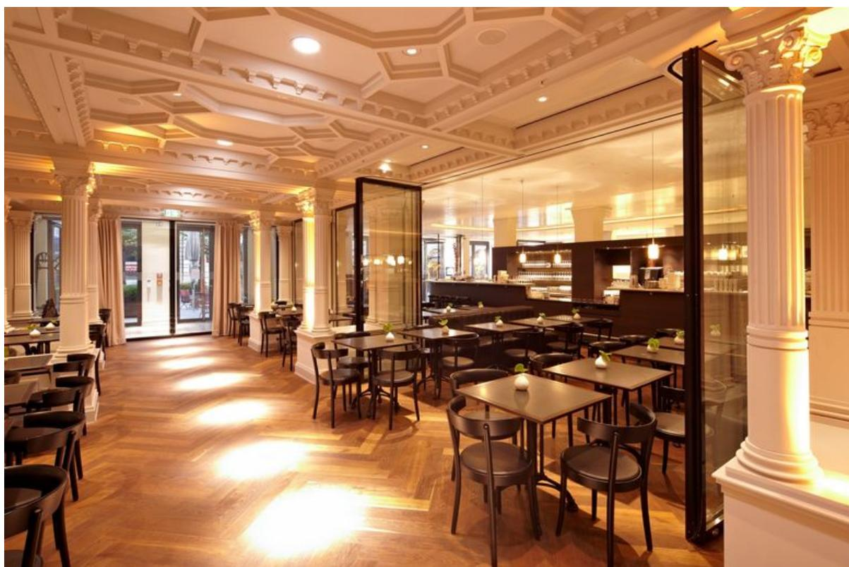
Elemento final de paredes móviles divisorias de vidrio con diseño IGG
